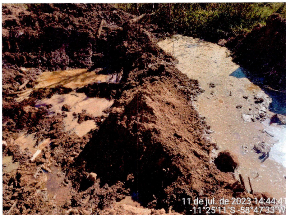
Figura 2 – Remoção de solo e recomposição de aterro Fonte: Prefeitura Municipal de Juína, 2023
