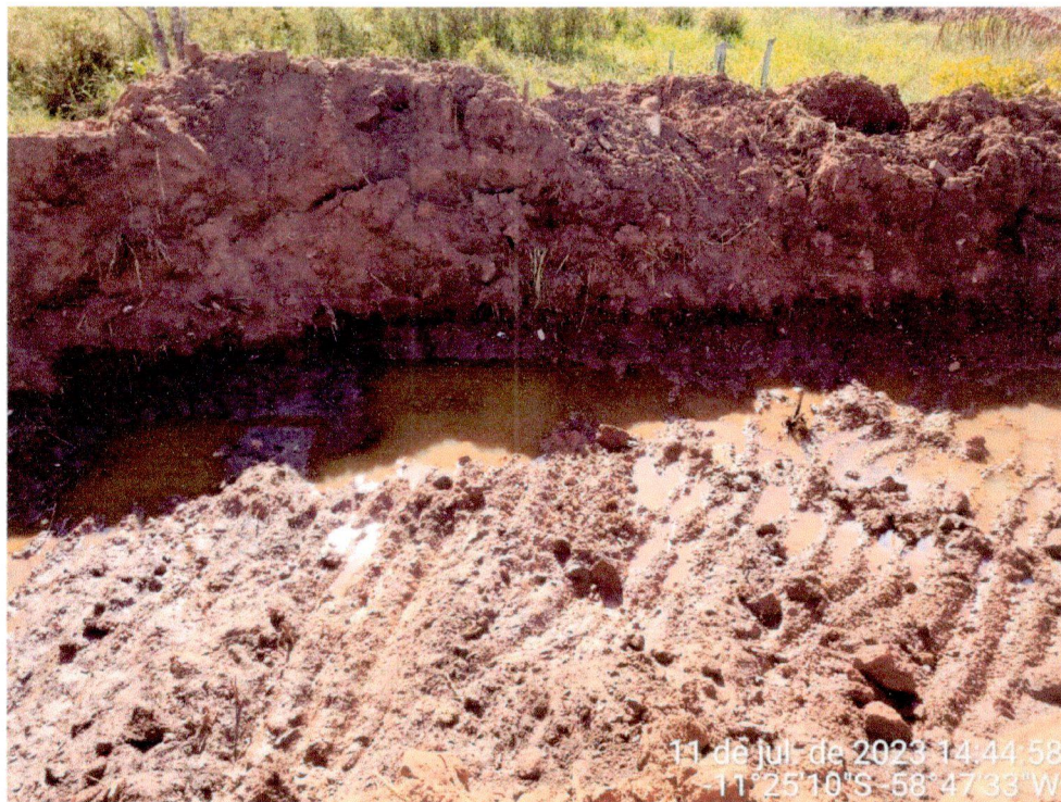
Figura 3 – Remoção de solo e recomposição de aterro Fonte: Prefeitura Municipal de Juína, 2023
