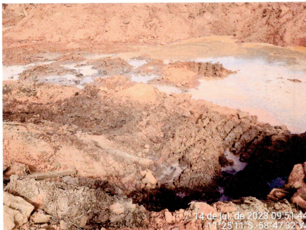
Figura 6 – Remoção de solo e recomposição de aterro Fonte: Prefeitura Municipal de Juína, 2023
