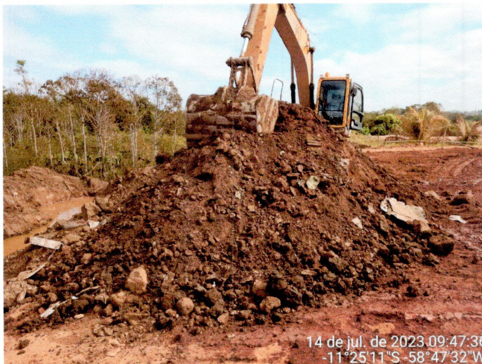
Figura 8 – Remoção de solo e recomposição de aterro Fonte: Prefeitura Municipal de Juína, 2023
