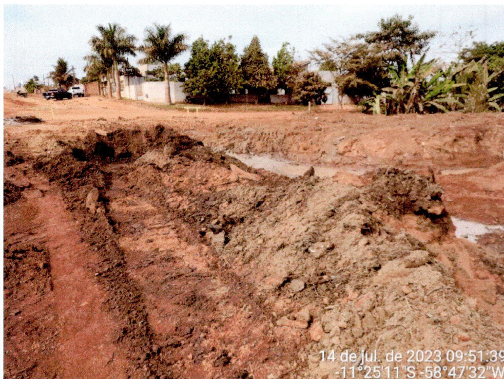
Figura 4 – Remoção de solo e recomposição de aterro Fonte: Prefeitura Municipal de Juína, 2023
