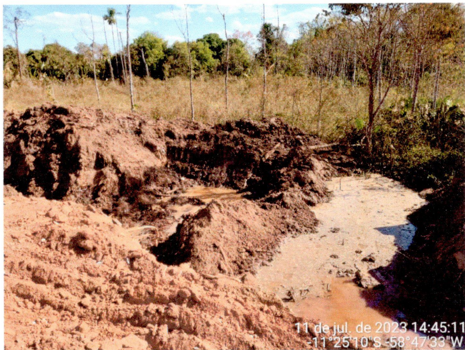
Figura 1 – Remoção de solo e recomposição de aterro Fonte: Prefeitura Municipal de Juína, 2023
