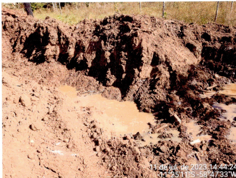
Figura 5 – Remoção de solo e recomposição de aterro Fonte: Prefeitura Municipal de Juína, 2023
