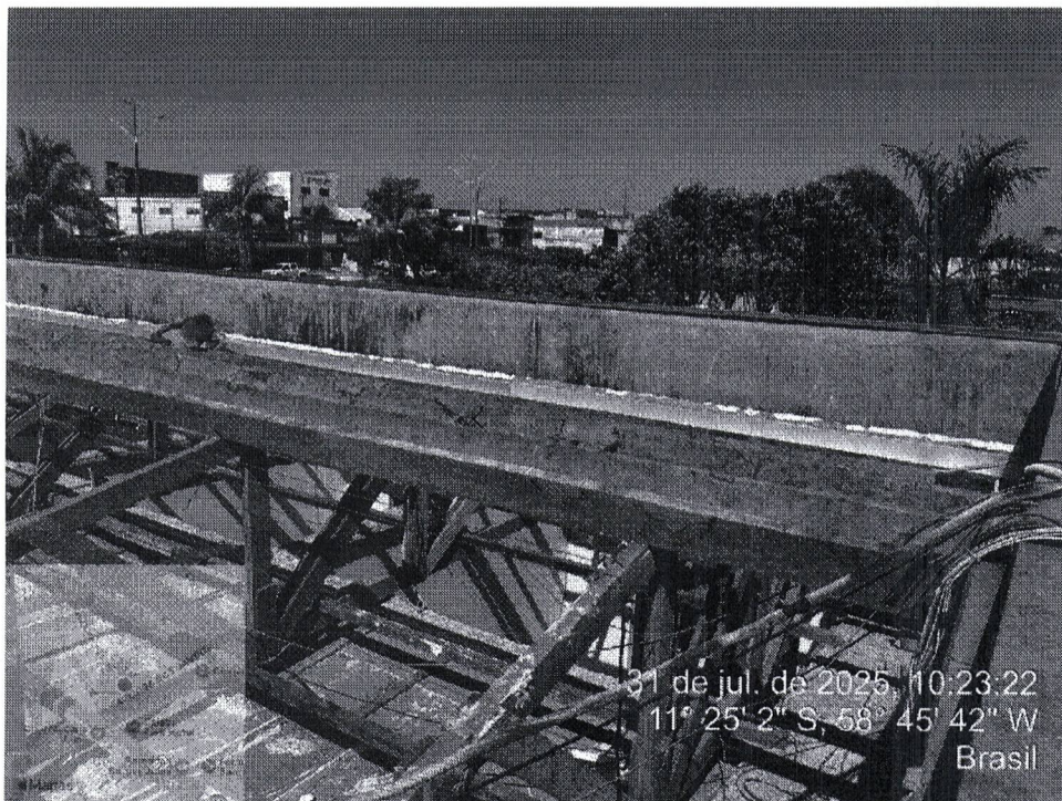
Foto 27 – Troca de telhamento, calhas, chapim e rufo, itens 2.1.2, 2.1.4, 2.1.5 e 2.1.6 Fonte: Prefeitura Municipal de Juína
