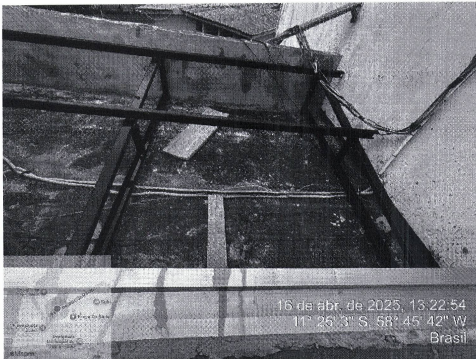
Foto 9 – Calhas e chapim, itens de 1.2.1 à 1.2.4 Fonte: Prefeitura Municipal de Juína
