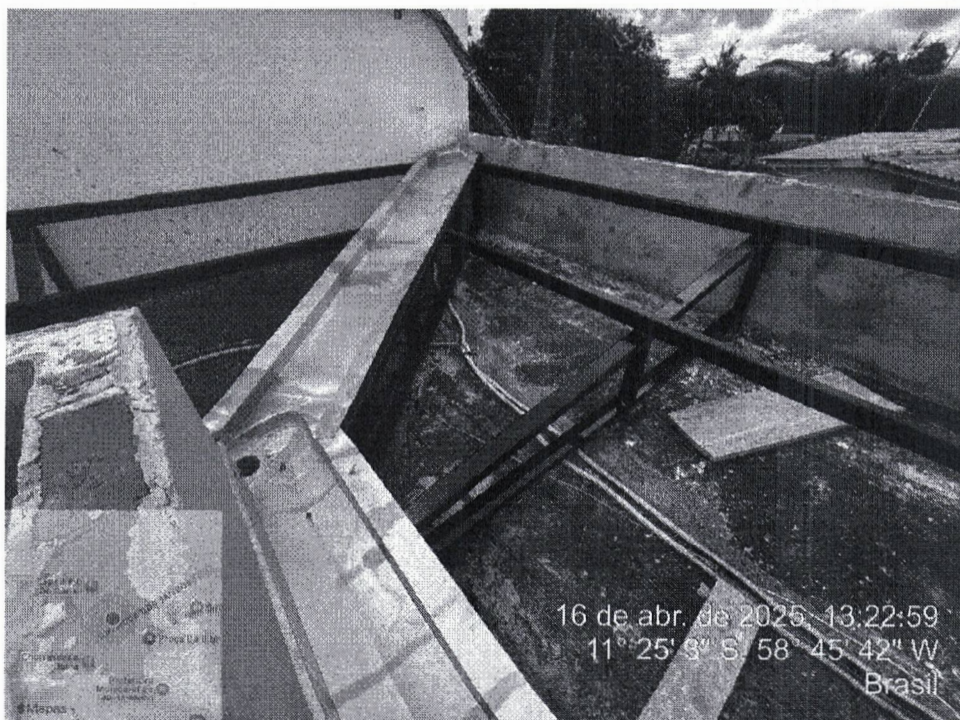
Foto 10 – Calhas e chapim, itens de 1.2.1 à 1.2.4 Fonte: Prefeitura Municipal de Juína
