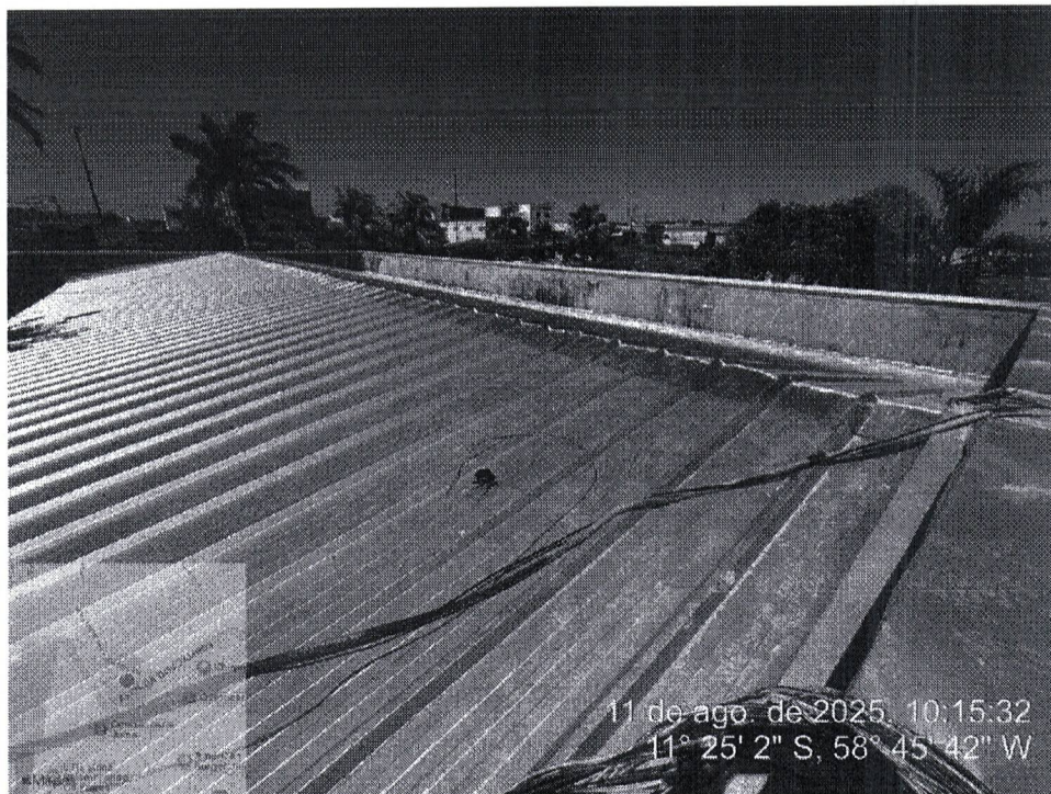
Foto 21 – Troca de telhamento, calhas, chapim e rufo, itens 2.1.2, 2.1.4, 2.1.5 e 2.1.6 Fonte: Prefeitura Municipal de Juína
