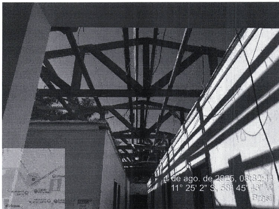
Foto 16 – remoção de telhas, calhas, chapim e rufos, itens 2.1.1 e 2.1.3 Fonte: Prefeitura Municipal de Juína
