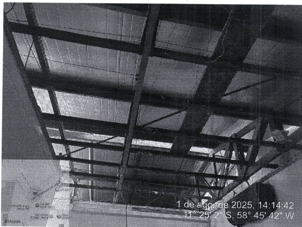
Foto 28 – Troca de telhamento, calhas, chapim e rufo, itens 2.1.2, 2.1.4, 2.1.5 e 2.1.6 Fonte: Prefeitura Municipal de Juína
