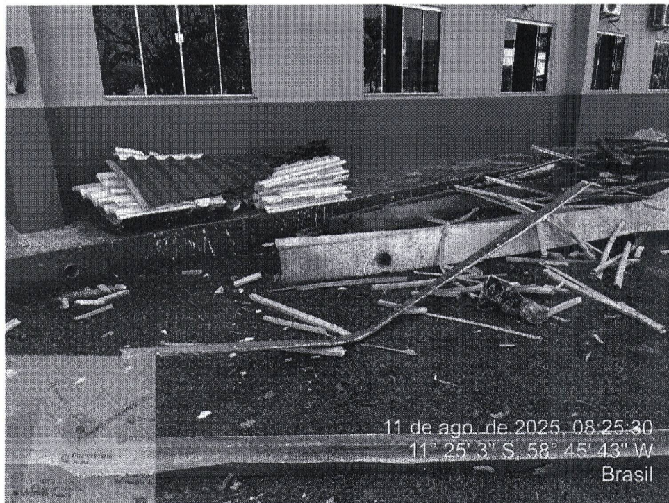
Foto 17 – remoção de telhas, calhas, chapim e rufos, itens 2.1.1 e 2.1.3 Fonte: Prefeitura Municipal de Juína
