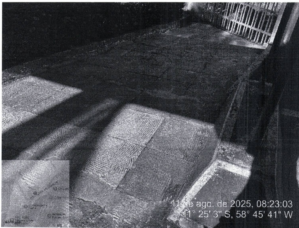
Foto 31 –demolição de revestimento ceramico, item 2.2.2 Fonte: Prefeitura Municipal de Juína
