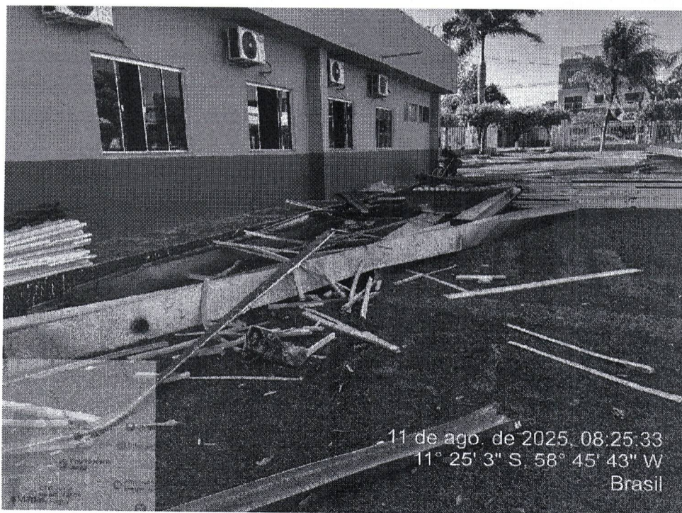
Foto 18 – remoção de telhas, calhas, chapim e rufos, itens 2.1.1 e 2.1.3 Fonte: Prefeitura Municipal de Juína
