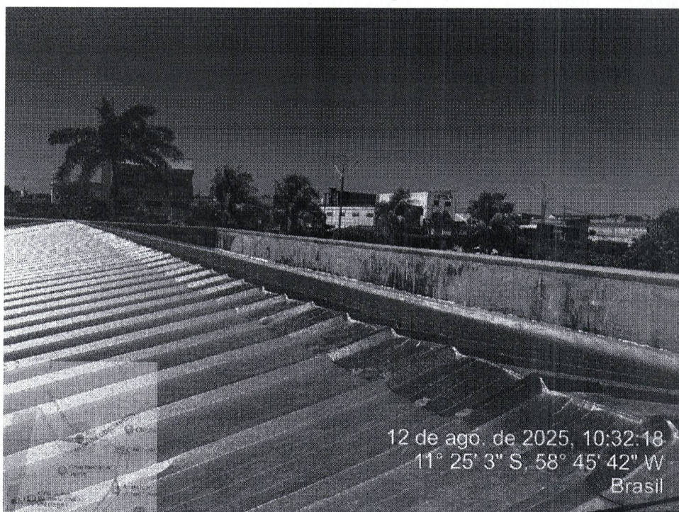
Foto 24 – Troca de telhamento, calhas, chapim e rufo, itens 2.1.2, 2.1.4, 2.1.5 e 2.1.6 Fonte: Prefeitura Municipal de Juína
