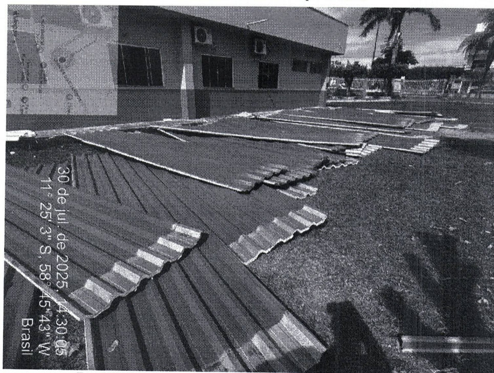
Foto 20 – remoção de telhas, calhas, chapim e rufos, itens 2.1.1 e 2.1.3 Fonte: Prefeitura Municipal de Juína
