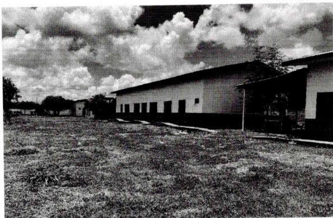
Lateral externa direita 2º Pavimento
