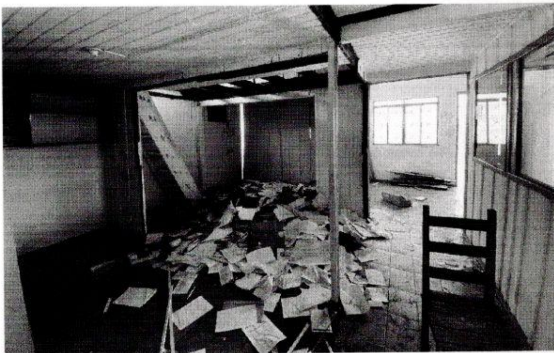
Parte interna salas e copa 1º Pavimento
