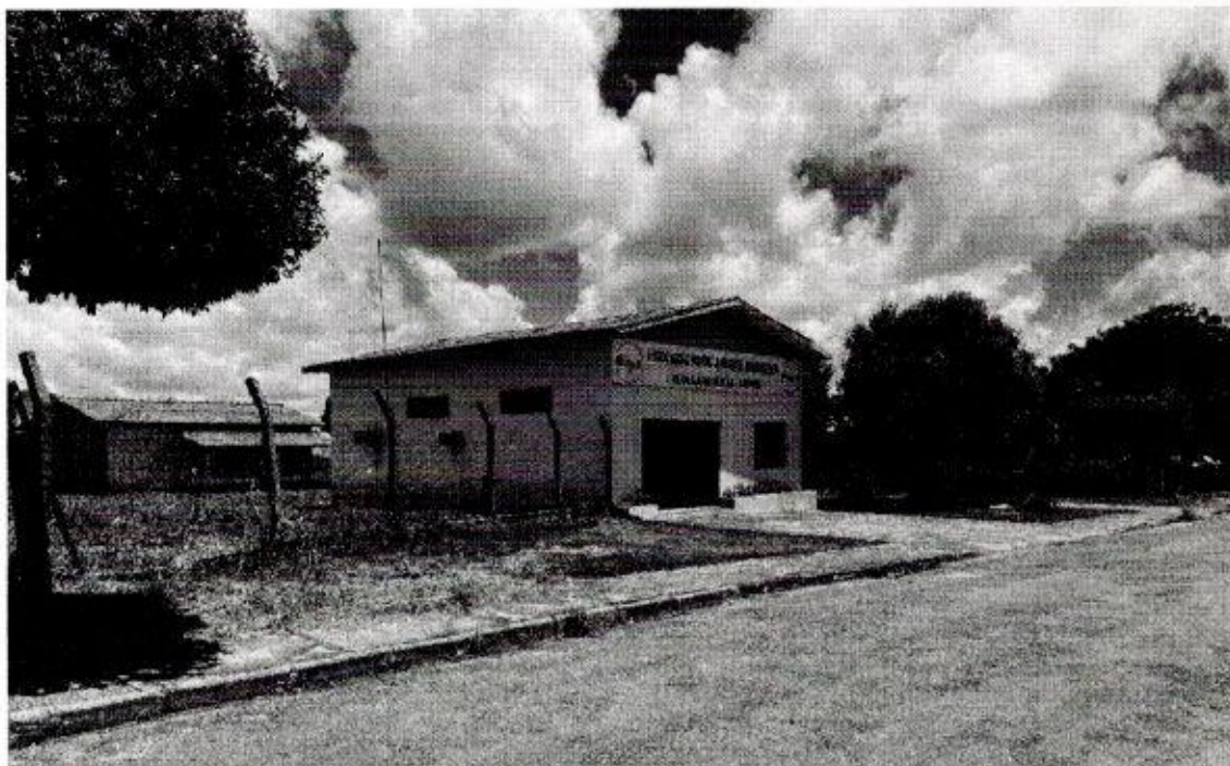
Lateral esquerda 1º Pavimento
