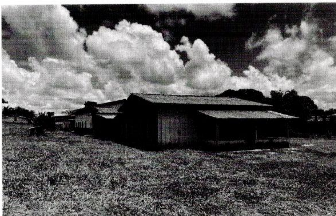
Lateral esquerda edificações de madeira – Obsoleto conforme mencionado na página 04.
