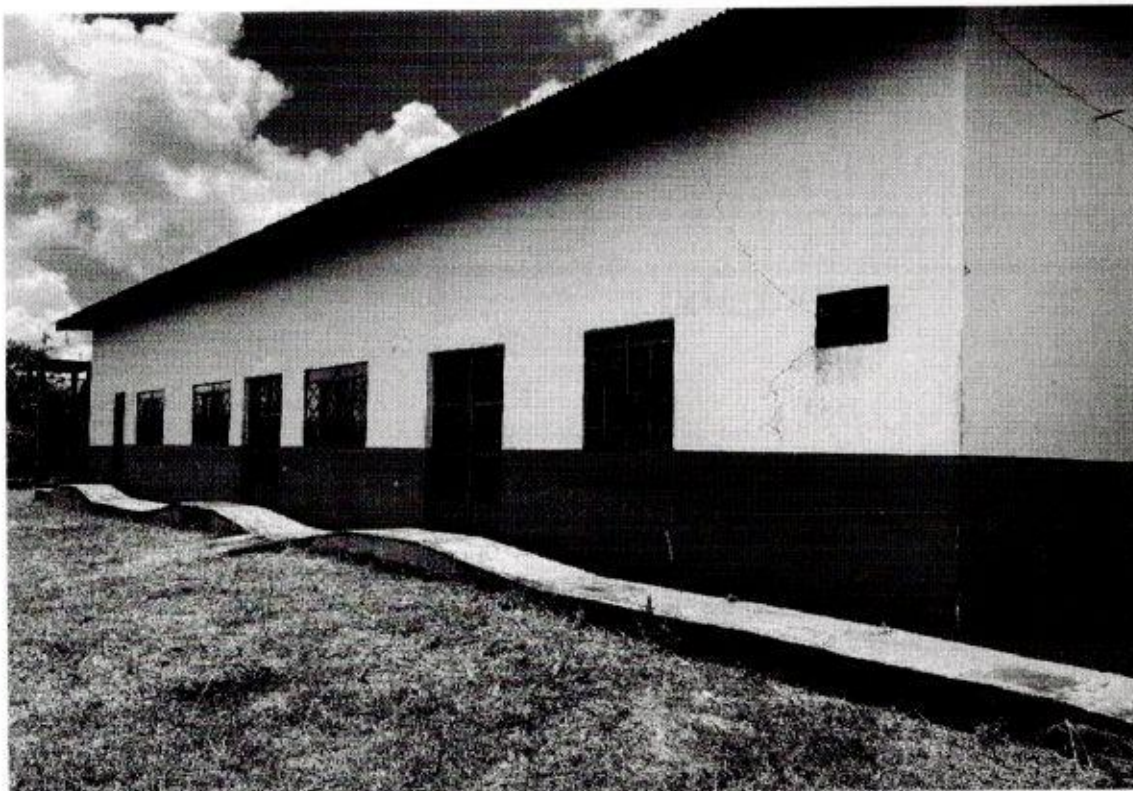
Lateral externa direita 2º Pavimento
