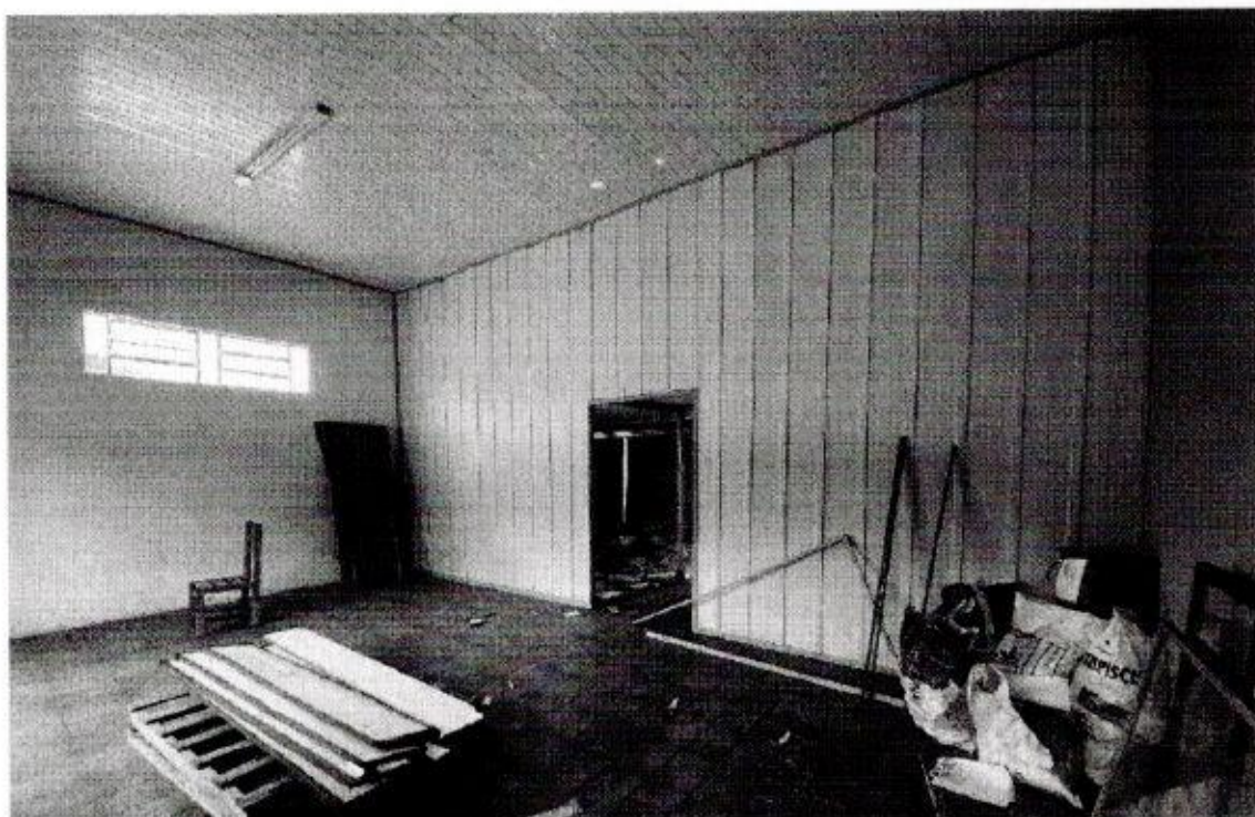
Parte interna recepção 1º Pavimento
