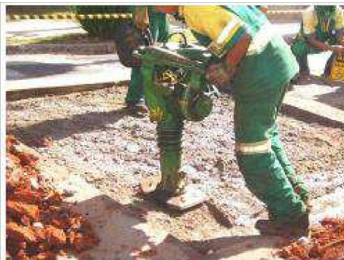
Figura 3: readequação da camada de base
