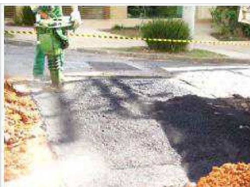
Figura 5: compactação do PMF
