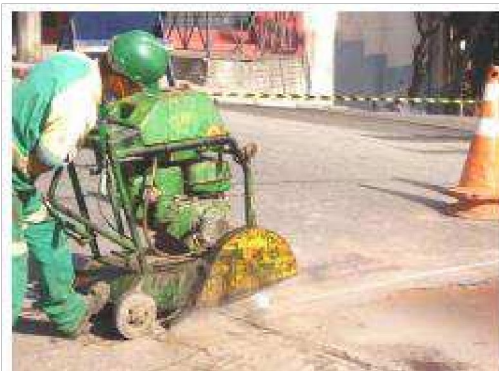
Figura 2: recorte da área danificada
