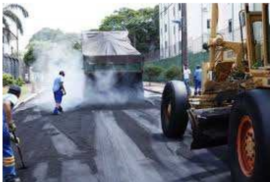
Figura 12: reperfilagem com CA
