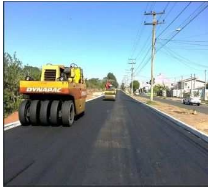
Figura 15: Execução de revestimento asfáltico
