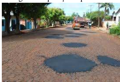
Figura 1: operação tapa buraco
