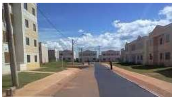
Figura 16: rejuvenescimento com micro revestimento asfáltico
