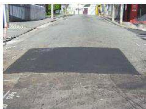
Figura 7: Remendo superficial executado
