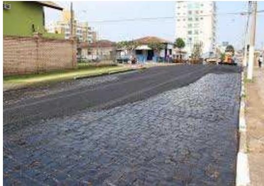
Figura 13: compactação do CA de reperfilagem
