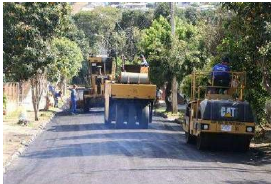
Figura 13: compactação do CA de reperfilagem
