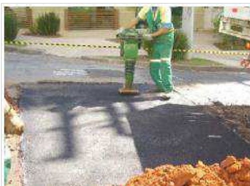
Figura 6: compactação do PMF
