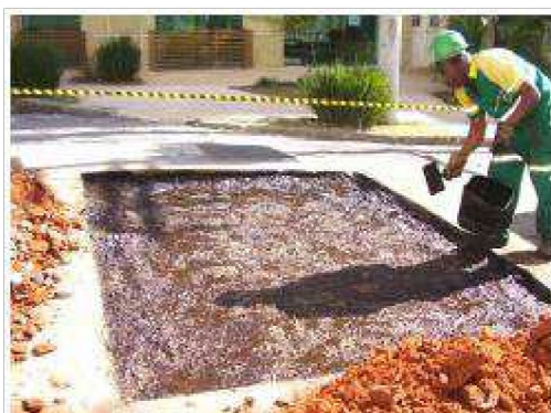
Figura 4: imprimação da camada de base
